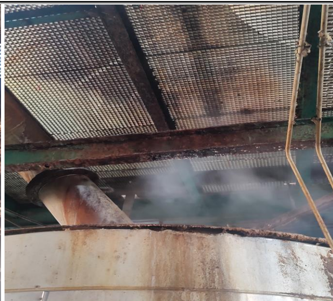
Слика 5. Дубинска корозија са бубрењем и деградацијом челика - Приказ деградације челичне конструкције кота +5м Оса Ц-Д
