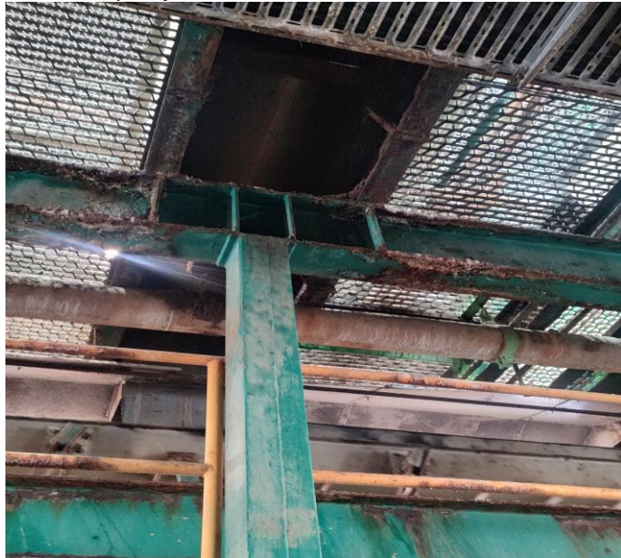
Слика 3. Дубинска корозија са деградацијом греде и стањењем челика
