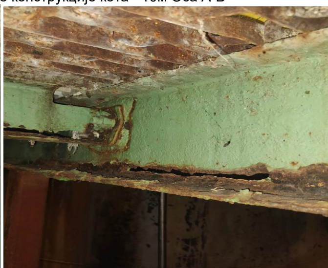
Слика 14 и 15. Дубинска корозија са деградацијом челика и потпуним стањењем челичног И профила
