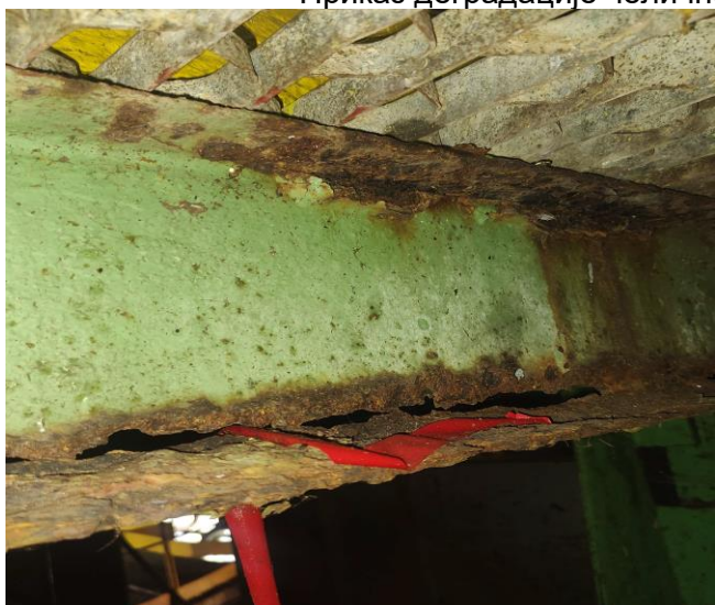
Слика 14 и 15. Дубинска корозија са деградацијом челика и потпуним стањењем челичног И профила
