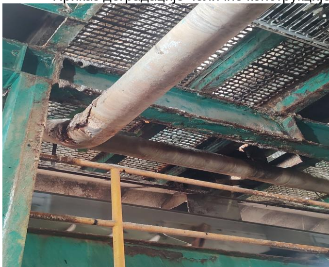
Слика 6. Површинска корозија са љуспањем
