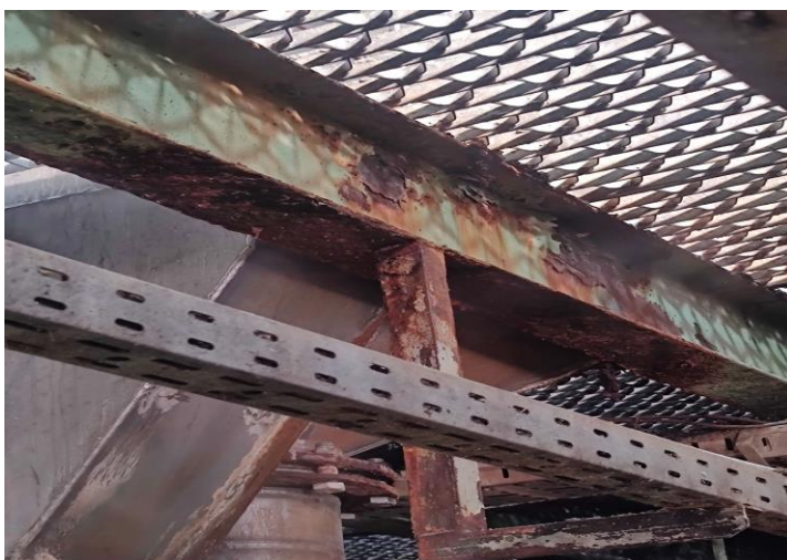
Слика 12 и 13. Површинска корозија са деградацијом челика и љуспањем као и стањењем елемената. Приказ деградације челичне конструкције кота +10м Оса А-Б
