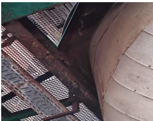
Слика 12 и 13. Површинска корозија са деградацијом челика и љуспањем као и стањењем елемената. Приказ деградације челичне конструкције кота +10м Оса А-Б
