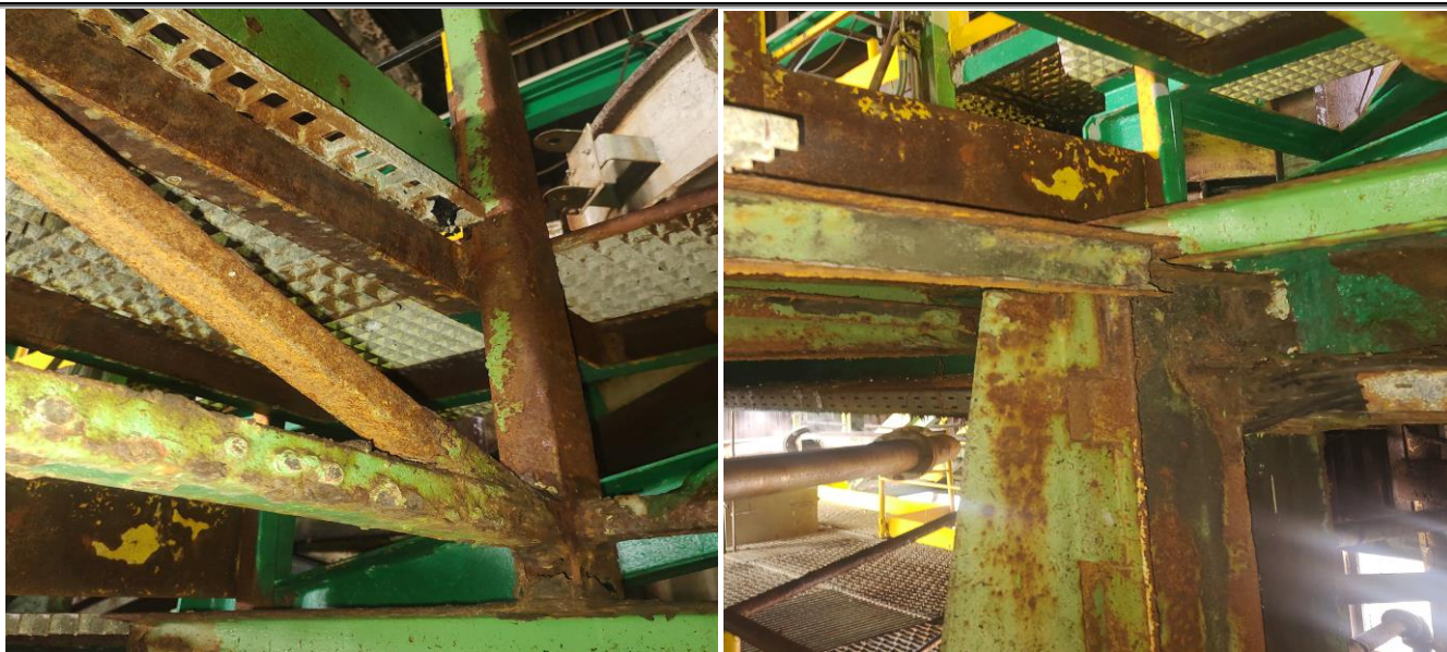
Слика 16 и 17. Дубинска корозија са деградацијом и ломом челика Приказ деградације челичне конструкције кота +10м Оса Ц-Д
