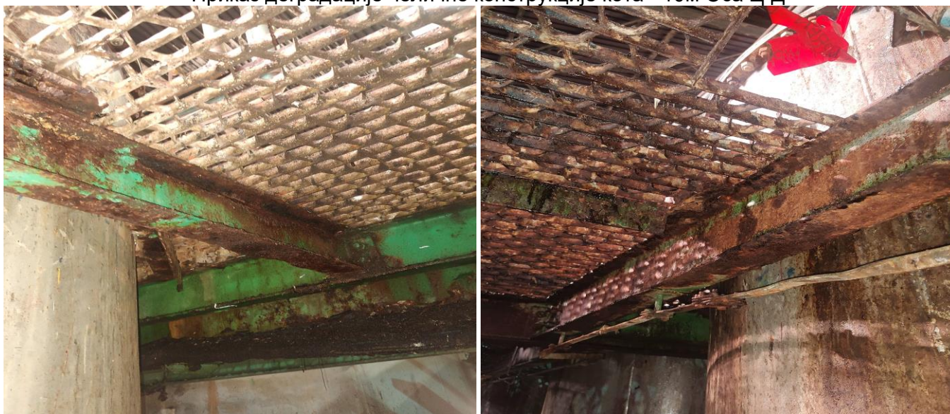
Слика 18 и 19. Дубинска корозија са деградацијом и бубрењем и љуспањем челика.
