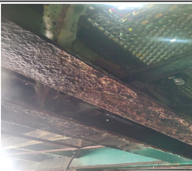
Слика 10 и 11. Дубинска корозија са деградацијом челика и љуспањем као и стањењем елемената. - Приказ деградације челичне конструкције кота +8м Оса Ц-Д
