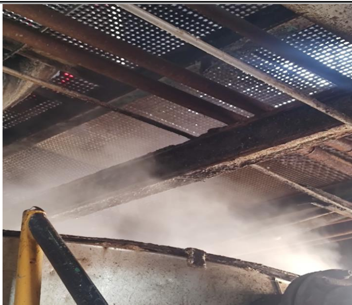
Слика 5. Дубинска корозија са бубрењем и деградацијом челика - Приказ деградације челичне конструкције кота +5м Оса Ц-Д
