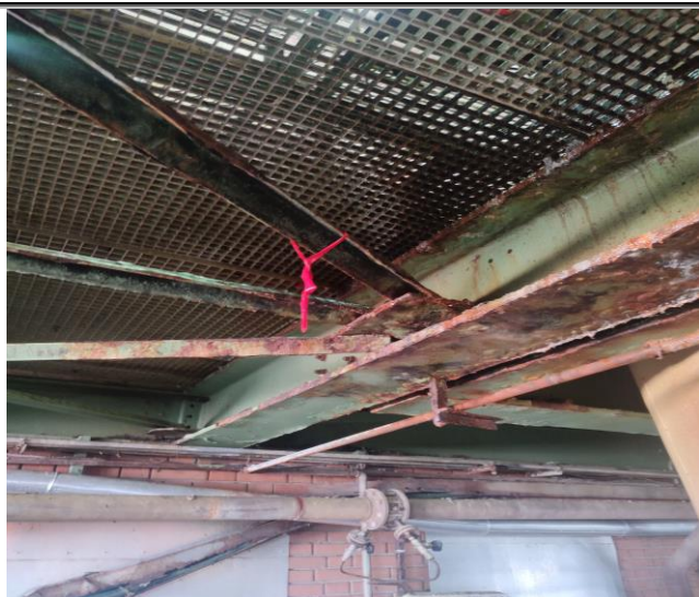
Слика 10 и 11. Дубинска корозија са деградацијом челика и љуспањем као и стањењем елемената. - Приказ деградације челичне конструкције кота +8м Оса Ц-Д
