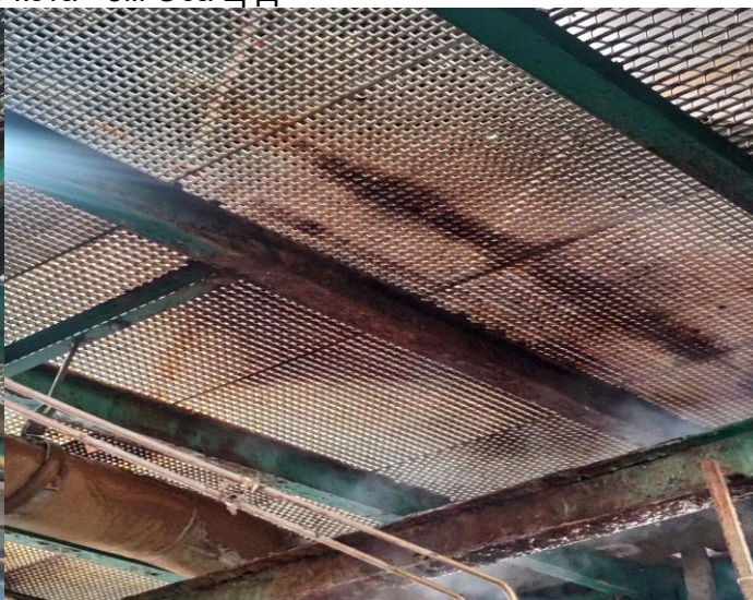
Слика 7. Дубинска корозија са бубрењем и деградацијом
